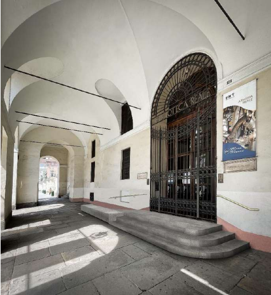
La nuova rampa di accesso alla Biblioteca Reale.
