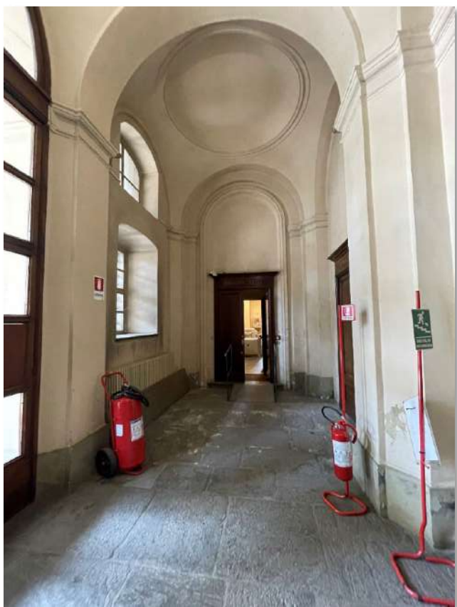
Lo stato attuale del vestibolo verso la Biblioteca
