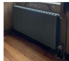
RADIATORE COSTITUITO DA 20 ELEMENTI (SPESSORE 17cm) CON VALVOLA DI SFIATO SUPERIORE E VALVOLA TERMOSTATICA ANCORATO CON STAFFE METALLICHE FISSATE A PARETE E PIEDINI METALLICI DI SUPPORTO A TERRA
