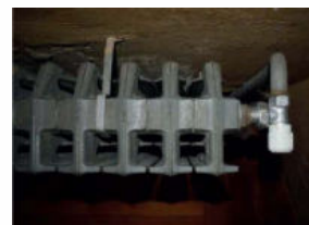
RADIATORE COSTITUITO DA 20 ELEMENTI (SPESSORE 17cm) CON VALVOLA DI SFIATO SUPERIORE E VALVOLA TERMOSTATICA ANCORATO CON STAFFE METALLICHE FISSATE A PARETE E PIEDINI METALLICI DI SUPPORTO A TERRA
