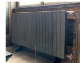
RADIATORE COSTITUITO DA 20 ELEMENTI (SPESSORE 12cm) CON VALVOLA DI SFIATO SUPERIORE E VALVOLA TERMOSTATICA ANCORATO CON PROFILI METALLICI FISSATI AL PAVIMENTO
