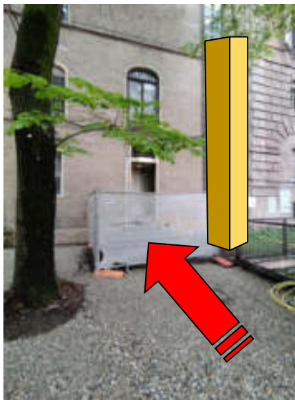
Accesso dai giardini al 1° piano con possibile posizione argano per salita in alto di materiale
