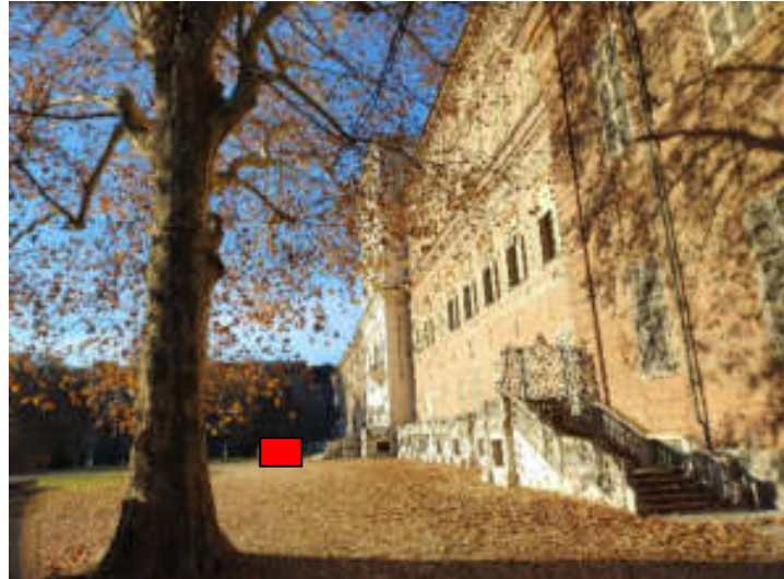
Collocazione zona di cantiere
