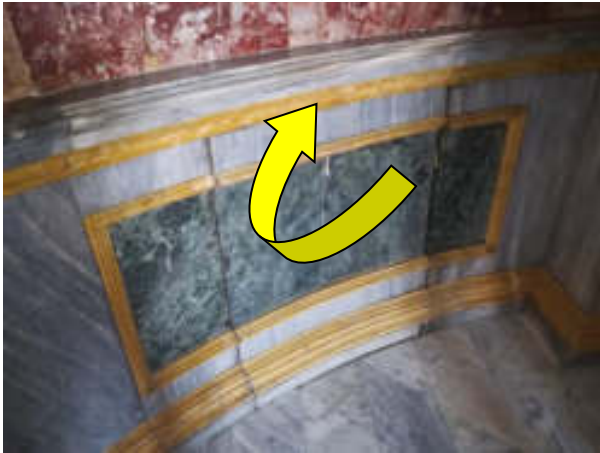
Pannello apribile per accedere all'estintore retrostante. Altezza circa cm. 100.
