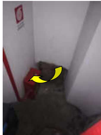
Pannello apribile per accedere all'estintore retrostante. Altezza circa cm. 100.
