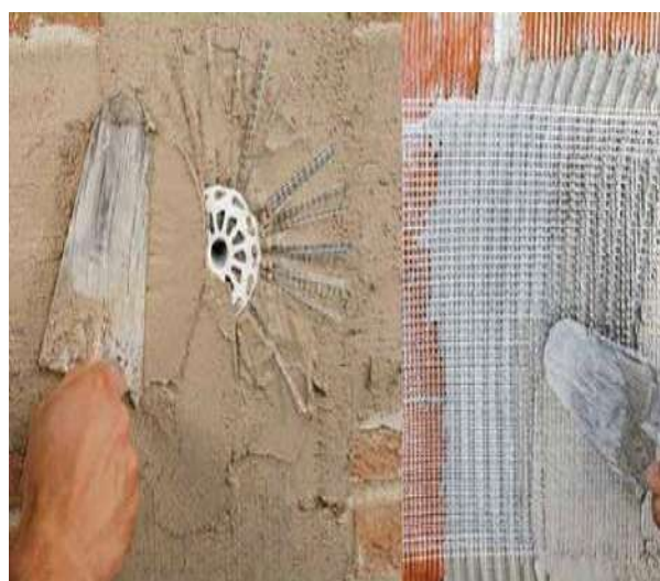
Figura 10 - stesura strato di finitura, geomalta a coprire i connettori a fiocco
